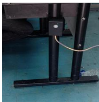
รูปที่ 3.1 การติดตั้งเซนเซอร์ตรวจจับความเคลื่อนไหว (PIR Motion Sensor)
