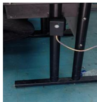
รูปที่ 3.3 การติดตั้งเซนเซอร์ตรวจจับความเคลื่อนไหว (PIR Motion Sensor)
